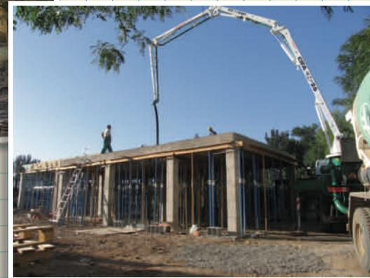
Detalle del encofrado de la cubierta de un edificio que enriquecerá notablemente las funciones del Centro de Recuperación.
